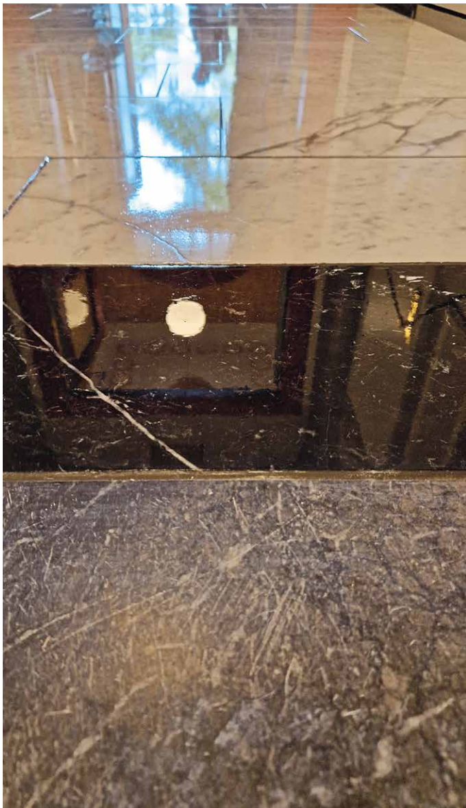
Endergebnis der rund fünfstündigen Reinigungsaktion: Der Marmorboden ist wieder vorzeigbar.
