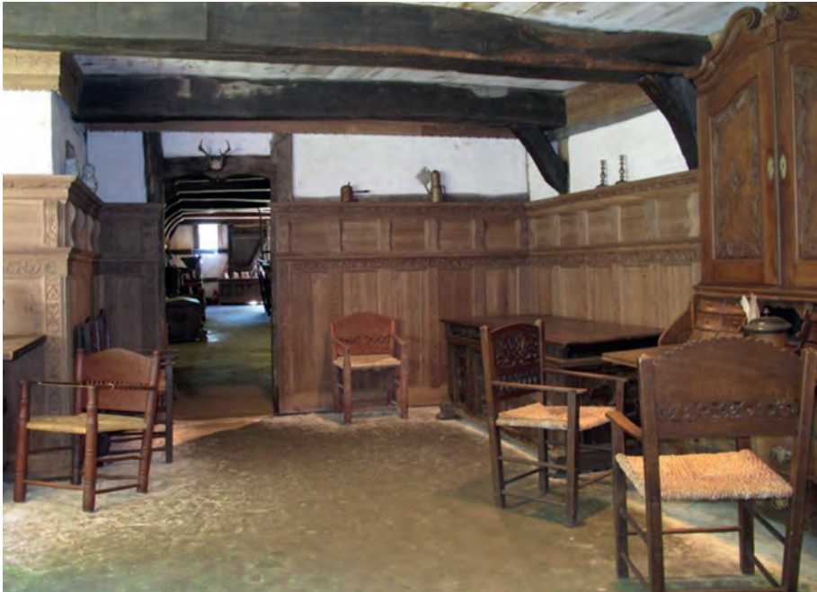
Lehmestrich in der „Pesel“, der „guten Stube“, im Ostenfelder Bauernhaus in Husum (Bild: Museumsverbund Nordfriesland).
