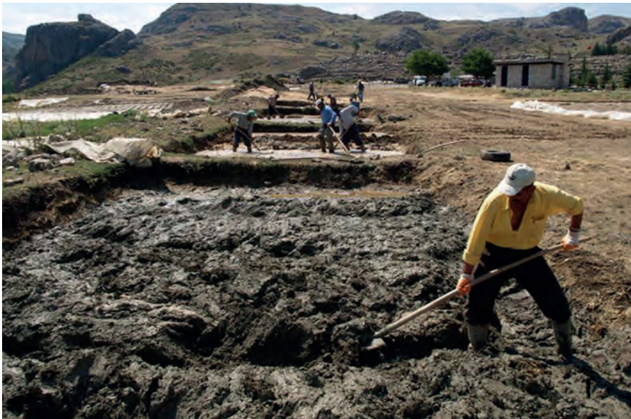
Mischen von Lehm nach der nassen Methode. Das Mischen erfolgt durch Treten mit den Füßen. Teilrekonstruktion der hethitischen Stadtmauer in Boğazköy-Hattuša (Bild: Archiv der Boğazköy-Expedition des Deutschen Archäologischen Instituts; Rekonstruktion einer hethitischen Stadtmauer [Jürgen Seher]).
