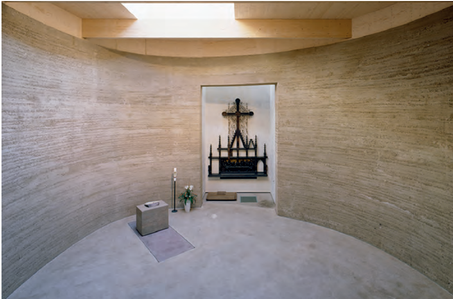
Versöhnungskirche Berlin. Tragende Wände und Fußboden aus Stampflehm (Bild: Bruno Klamfar, Architektur Rudolf Reitermann und Peter Sassenroth, Ausführung Lehm Ton Erde Baukunst GmbH).
