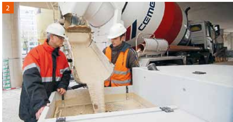
2 Fertigmörtel aus dem Fahrmischer. Der Lieferant stellt die Leistungserklärung für den Mörtel aus. Verlegt der Estrichleger nur diesen Mörtel, z.B. auf eine vom Heizungsbauer verlegte Dämmung, kann er diese Leistungserklärung verwenden. Stellt er daraus einen schwimmenden Estrich mit selbst gelieferter und eingebauter Dämmschicht her, stellt er eine Leistungserklärung für den „Bausatz“ schwimmender Estrich aus, indem er die Leistungserklärungen der Bestandteile zusammenfasst. Foto: Lanxess
