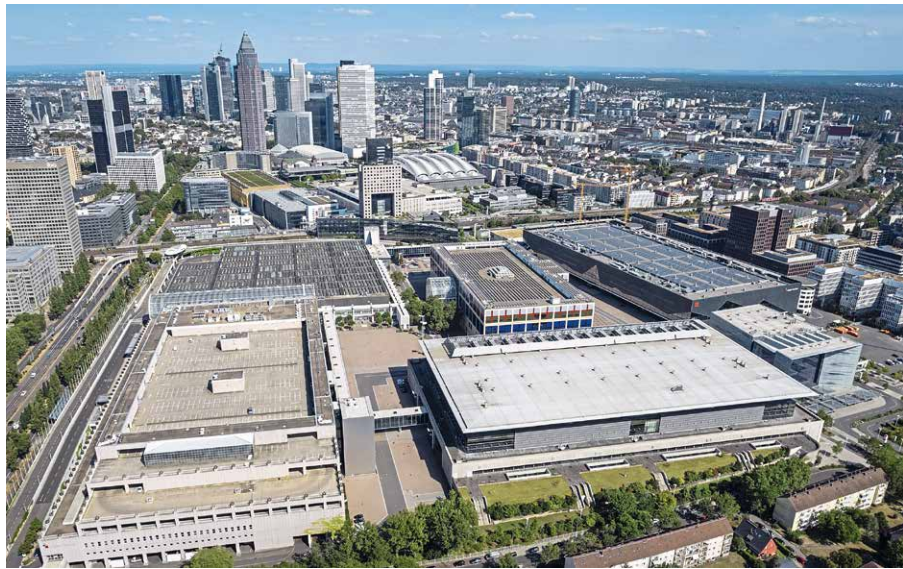
Verteilt auf elf Hallen verfügt die Messe Frankfurt über rund 400.000 Quadratmeter Veranstaltungsfläche, die es instand zu halten gilt.
