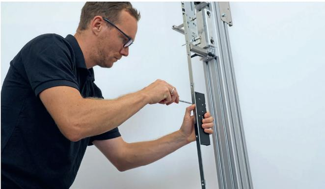
**3. Schritt:** Setzen Sie die Antriebseinheit in den Stulp ein und verschrauben Sie sie mittels der vorgefertigten Bohrungen.
