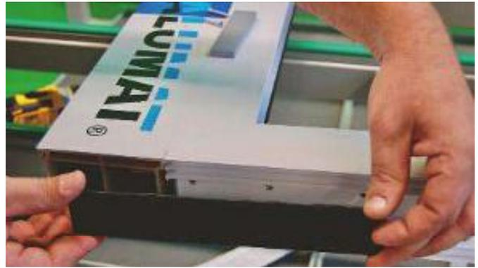
2. Schritt: Bringen Sie die Klemmleiste am Rahmenrücken an – die Markierung OKFF hilft bei der Ausrichtung in der Höhe.
