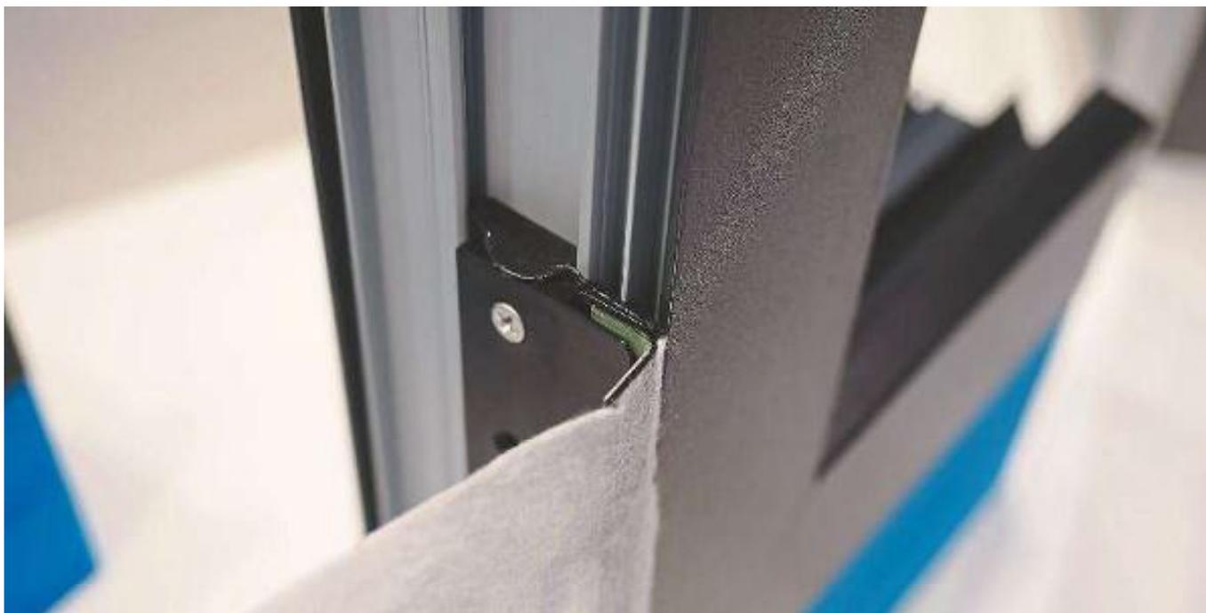
Den **zweiteiligen Flansch** zur Abdichtung bodentiefer Elemente hatte Alumat auf der Bau in München in den Fokus des Interesses gerückt. Die Lösung ist dem Unternehmen zufolge bereits rege nachgefragt.
