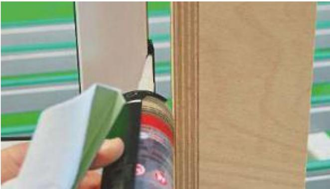
5. Schritt: Auf der Baustelle bringen Sie mit der Kartuschenpresse eine Dichtstoff-Raupe in die Nut der Klemmleiste ein.
