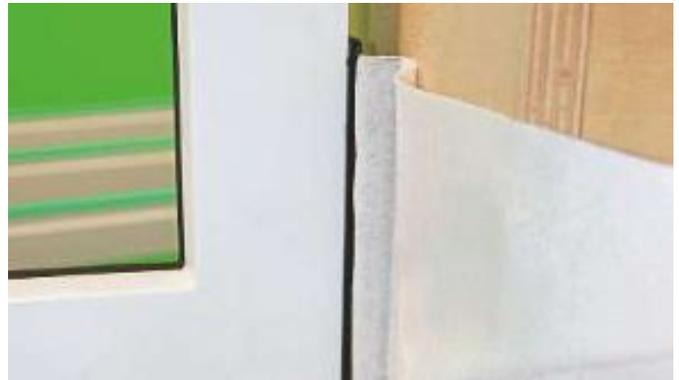
6. Schritt: Schieben Sie das Verbundblech mit dem teilverschweißten Vliesformteil in die Nut und drücken Sie es an.
