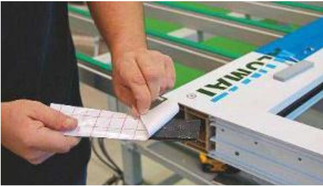
1. Schritt: Ziehen Sie von der mit einem Butylband versehenen Klemmleiste den Trennstreifen ab.
