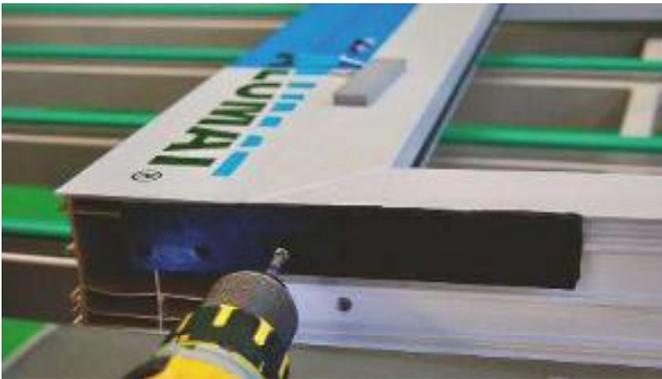
3. Schritt: Zusätzlich zum Butylband schrauben Sie die Klemmleiste für eine sichere Befestigung am Rahmenrücken an. Sieben Löcher sind zu diesem Zweck vorgebohrt.
