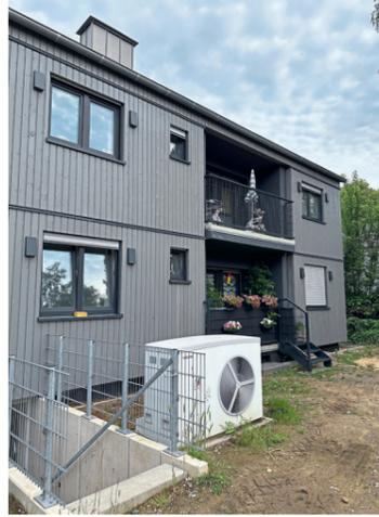
Mehrfamilienhäuser in Mönchengladbach-Hardt wurden mit vorgefertigten Holzfassaden versehen, inklusive Lüftungstechnik und Dämmung. So ausgestattet, bieten die Häuser gute Voraussetzungen für den effizienten Betrieb der neuen Wärmepumpen.
