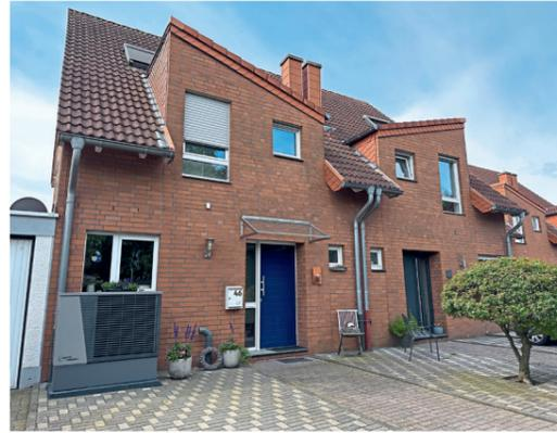
Auch für Reihenhäuser bieten Wärmepumpen wirtschaftliche Heizlösungen. In Kombination mit Gebläsekonvektoren laufen sie besonders effizient und ermöglichen auch das Kühlen.
