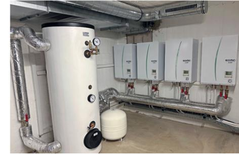
Mit einer Vierer-Kaskade mit insgesamt 56 kW Leistung wird der Bilker Bunker versorgt. Eine weitere Zweier-Wärmepumpen-Kaskade bedient die Wohnungen.
