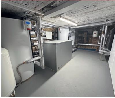
Altbau und Wärmepumpe schließen sich nicht aus, in Krefeld Oppum ist ein perfektes Match. Das Acht-Parteien-Wohnhaus wird mit einem erdgekoppelten System und einer Hochtemperaturwärmepumpe beheizt.
