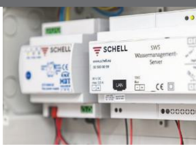
Das Schell Wassermanagement-System SWS/Smart.SWS ermöglicht nach entsprechender Programmierung die automatische Auslösung von Stagnationsspülungen zum Erhalt der Trinkwassergüte.
