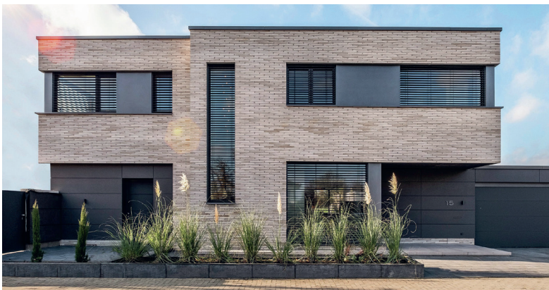
Einfamilienhaus in Steinfurt: Die spezielle Lamellenneigung der Pro-Visio-Raffstores verbindet Sonnenschutz mit optimaler Durchsicht.
