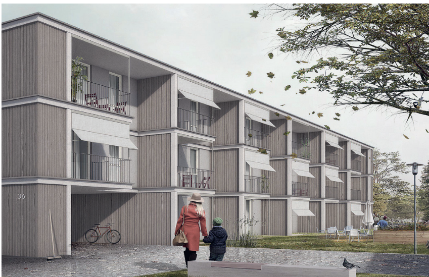
Bei einem Neubau für die Wohnungsbaugenossenschaft im Raum Pfaffenhofen hatten die Nutzeranforderungen höchste Priorität: Textile Senkrechtmarkisen in den Obergeschossen lösen hier Vorbaurollläden im Erdgeschoss ab.
