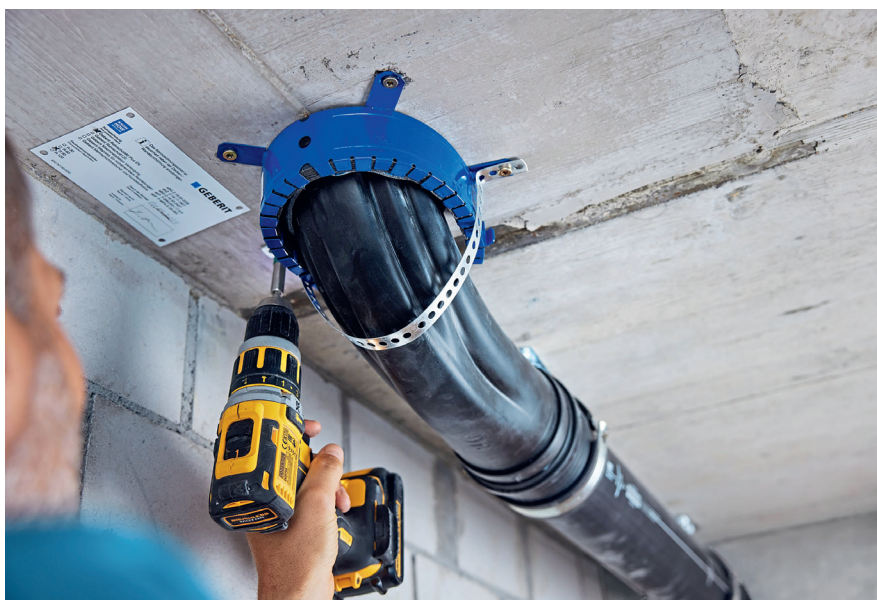
Die aufgesetzte Installation des Rohrschotts in U-Form ermöglicht einen minimalen Deckenabstand, ohne erhöhten Installationsaufwand. Der Silent-Pro BottomTurn Bogen ist mit zwei Steckenden ausgestattet und kann daher gegenläufig gesteckt werden.
