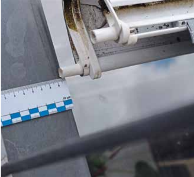
Das Ausfallprofil bleibt am Zinkblech der Balkonverkleidung hängen. Sechs Millimeter beträgt der Überstand an dieser Stelle.
