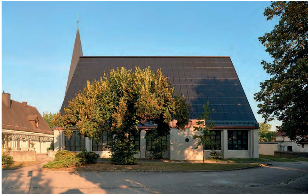
Bei der Begehung vor dem Baubeginn lässt sich feststellen, ob die Module verschattet sind. Hier wirft die alte Linde in den frühen Morgenstunden einen Schatten auf das Dach. Der verschwindet aber, wenn die Sonne in den nächsten Stunden weiterwandert. (© SOLARWATT GmbH)
