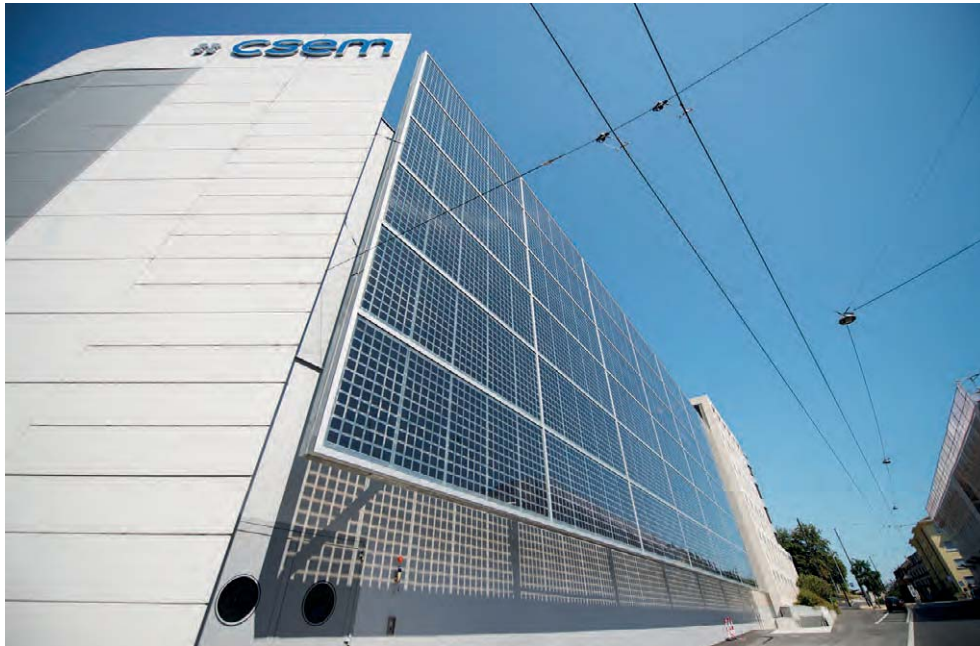
Auch große hinterlüftete Fassaden lassen sich mit Solarmodulen bauen, wie das Projekt am Forschungsgebäude des Centre Suisse d'Electronique et de Microtechnique (CSEM) in Neuchâtel zeigt. Durch die semitransparenten Module wirkt die Fassade trotz ihrer riesigen Ausmaße dennoch leicht. (© CSEM SA/David Marchon)
