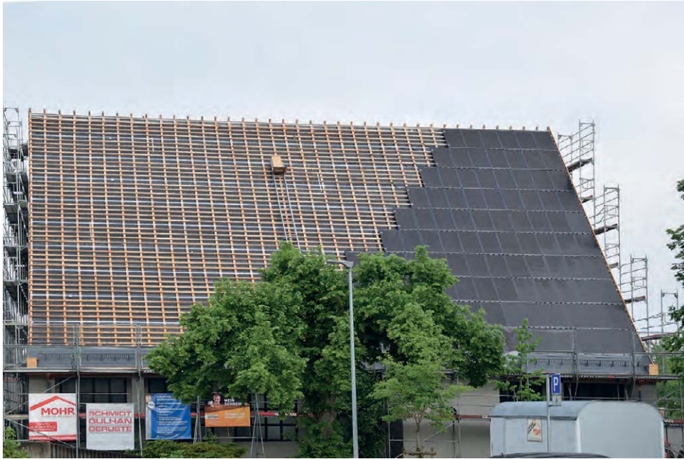
Mit der solaren Indachanlage kommt ein weiteres Gewerk auf die Baustelle. Deshalb sollte vorher geklärt werden, wo der Elektrohandwerker vom Dachdecker übernimmt. (© SOLARWATT GmbH)
