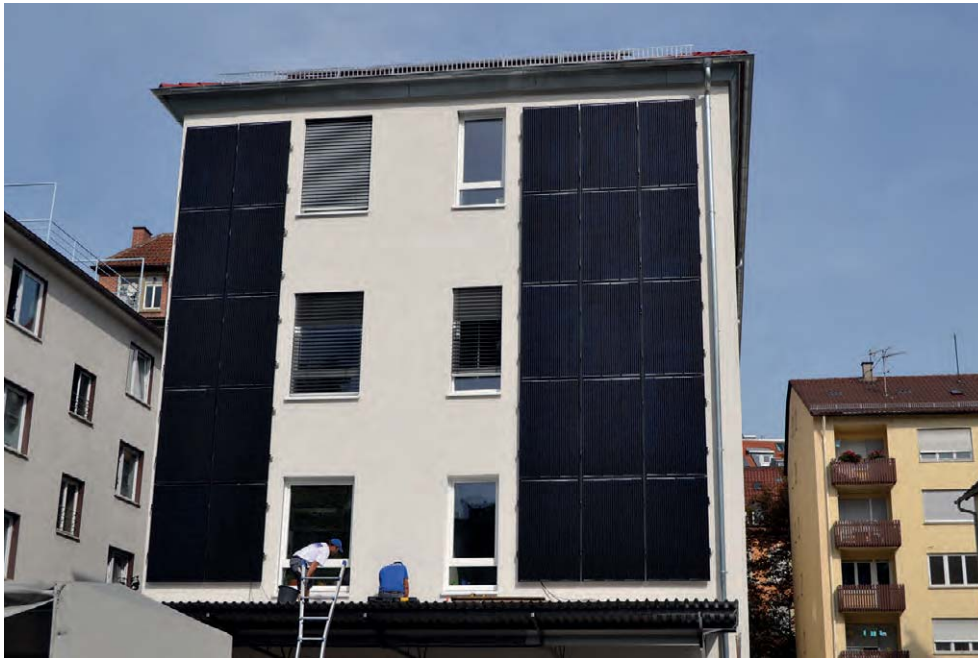
Nach Süden ausgerichtete Solar- fassade im Westen von Stuttgart. (© Stadtwerke Stuttgart/ Leif Piechowski)
