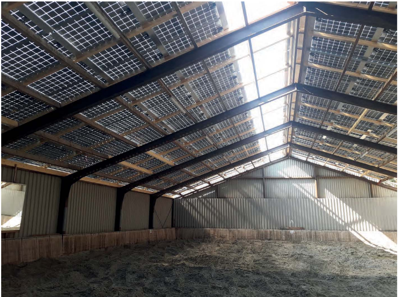
Die Planer des niederländischen Solarprojektierers Zonel haben das Dach einer Reithalle der Hollandsche Manege in Amsterdam mit semitransparenten Solarmodulen eingedeckt. Die Module der Sonnenstromfabrik aus Wismar sind nicht nur das Herz eines modernen Energiekonzepts des historischen Reitzentrums. Sie sorgen auch für eine einzigartige Lichtstimmung in der Halle. (© Sonnenstromfabrik.com)
