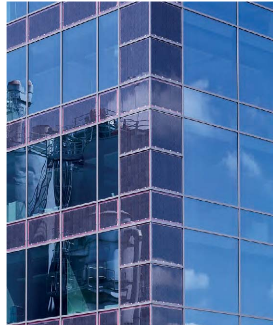
Eine filigrane Pfosten-Riegel-Konstruktion im Detail: Das neue Verwaltungs- und Bürogebäude von Swiss Krono in Menznau. (© Meyer Burger)
