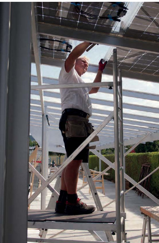
Installation einer solaren Überkopfverglasung. (© Schindler clean energy systems)
