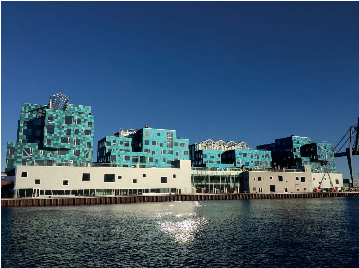
Das neue Gebäude der Copenhagen International School – entworfen von Julian Weyer, Partner beim Kopenhagener Architekturbüro C.F. Møller Architects – steht im einstigen Containerhafen der dänischen Hauptstadt. Nicht nur der Baukörper besticht durch seine Einzigartigkeit. Auch die Fassade ist mit einem ganz besonderen Effekt versehen. Die dort angebrachten Solarmodule erscheinen in unterschiedlichen Farbabstufungen – je nach Betrachtungswinkel. (© 2017 EPFL/Philippe Vollichard)
