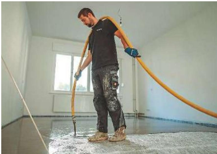
Glasfaserarmierungsmatten kommen zur flächigen Armierung von spinnennetzartig gerissenen Untergründen zum Einsatz und eignen sich besonders auch zur maschinellen Verarbeitung von Bodenspachtelmassen. Somit stellt diese Ausführung eine besonders effiziente Lösung dar.
