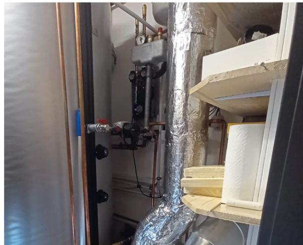
Eine Mini-Wärmepumpe im Hausaufstellungsraum direkt neben dem Pufferspeicher unterstützt die thermische Aktivierung der Betonbodenplatte.
