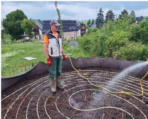
Beim Bau des Mikroben-Biomeilers: Bevor der Kompost geschichtet wird, werden die Rohrleitungen für den Abtransport der Wärme verlegt.
