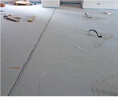
Fachgerecht ausgebildete Bewegungsfuge in einem beheizten Calciumsulfatfließestrich.
